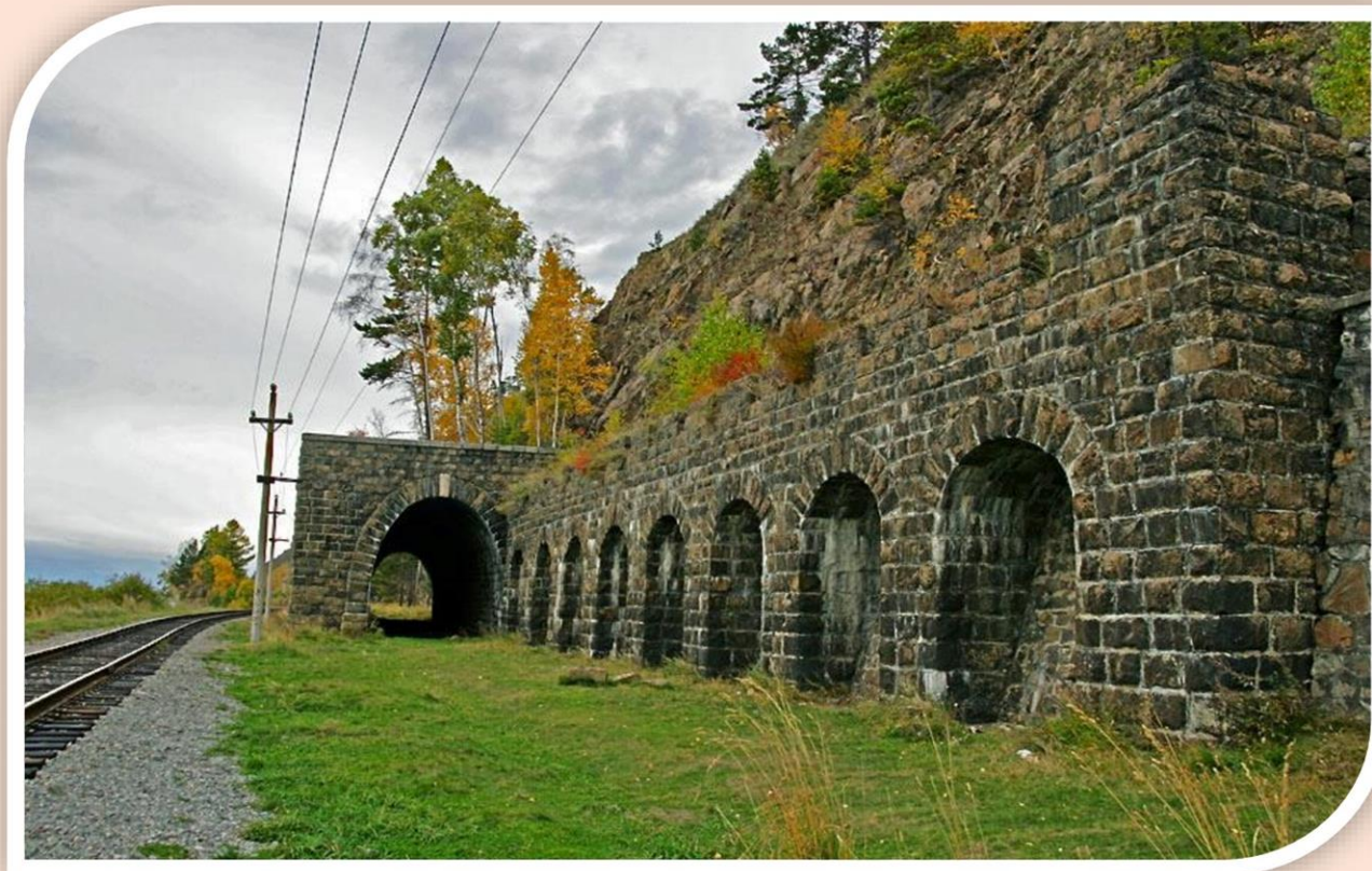
Итальянская подпорная стенка. 2020г.
